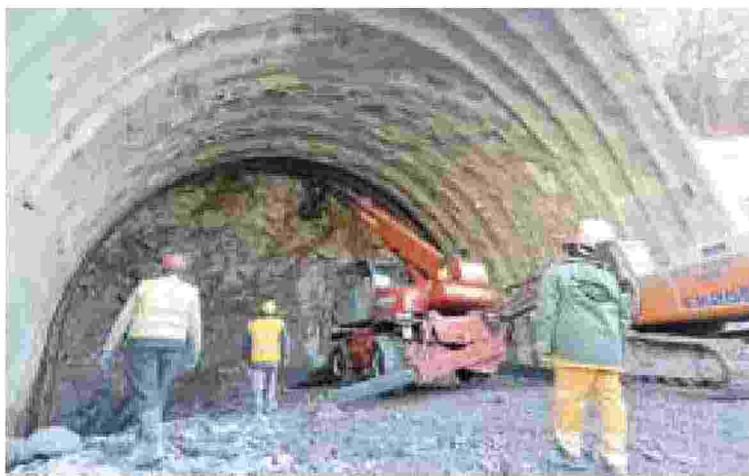
Lavori nel cantiere del Terzo valico a Genova
